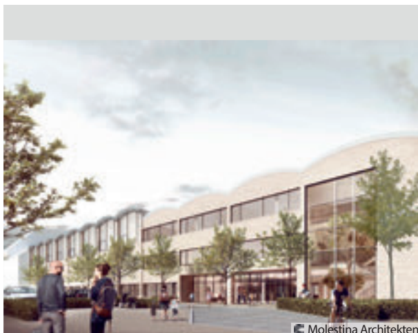
Molestina Architekten IGIS - Integrierte Gesamtschule Innenstadt - Severinswall 40, Köln Entwurf + GP : Molestina Architekten Ges. für Architektur mbH TU : Fritz Meyer Bauunternehmung GmbH
