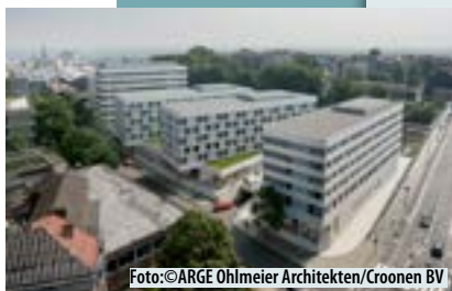
Foto:©ARGE Ohlmeier Architekten/Croonen BV
